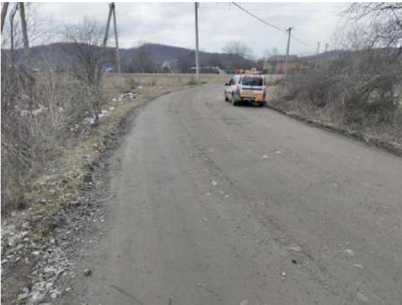
Общий вид (фото)
