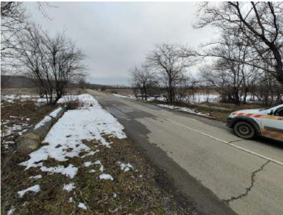
Общий вид (фото)
