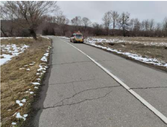
Общий вид (фото)
