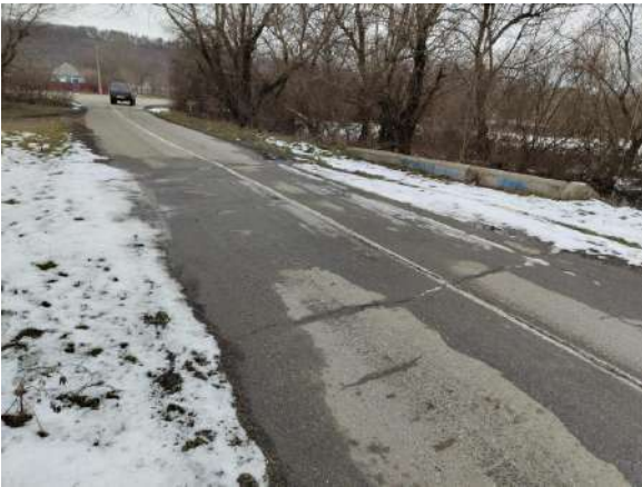
Общий вид (фото)
